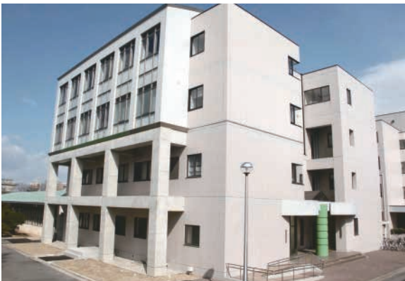
地域共同テクノセンター棟 Collaborative Research Center Building
