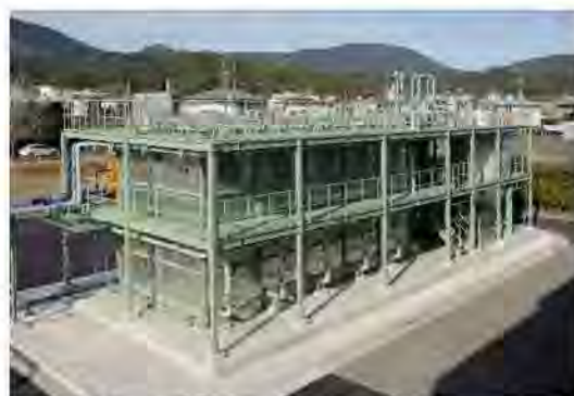
図2 DHS下水処理システムの外観写真
