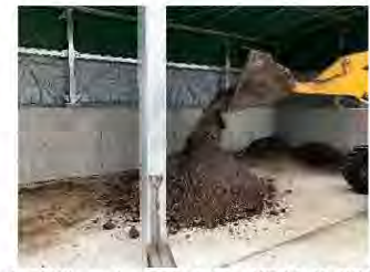
〈重機による資材の攪拌作業〉
