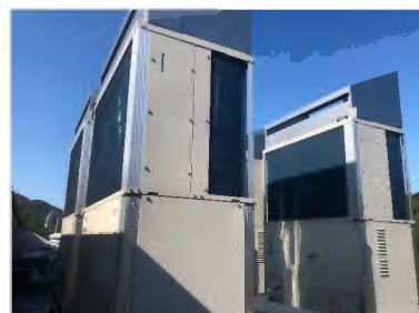
<舞鶴高専：空調設備改修>
