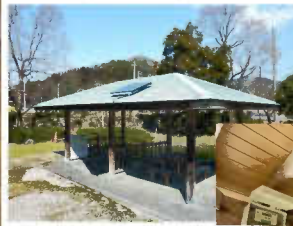
中部電力(株)を通して、普通に照明を使うと
