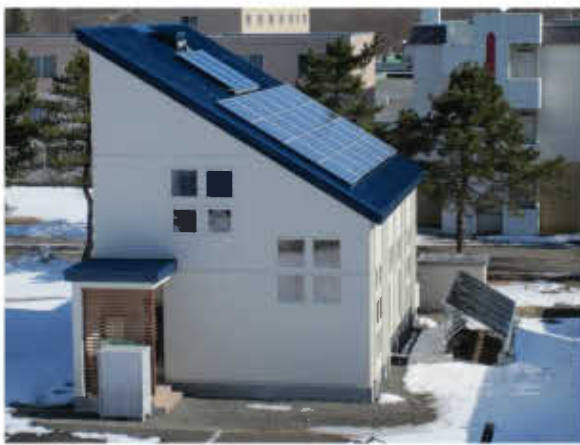
太陽光発電モジュール(2kW+4kW)
