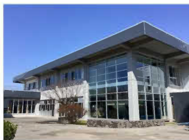
<秋田高専：図書館改修>
