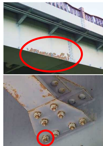
旭川市の橋の腐食 腐食
