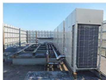
鈴鹿高専：空調設備改修
