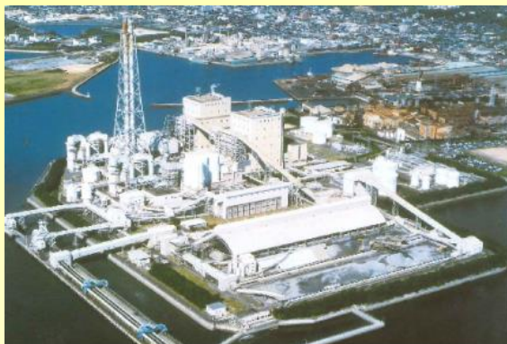
新小野田発電所
