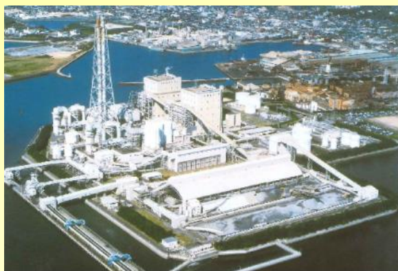
新小野田発電所
