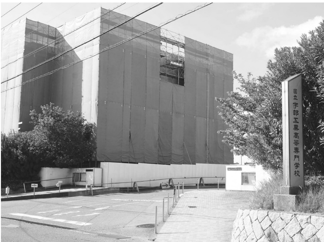
正門横に建設が進む情報教育棟「アイキューブ」
